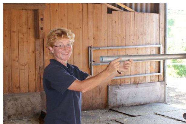
Mittels ausziehbaren Rohren lässt sich eine Boxe vom Gruppenbereich abtrennen.
