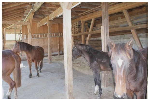
Nur Dachstützen unterteilen den Stall
