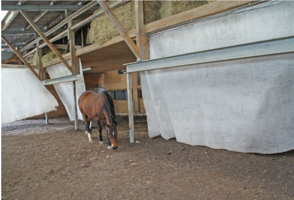
Liegehalle mit Vliesen als Raumteiler.
