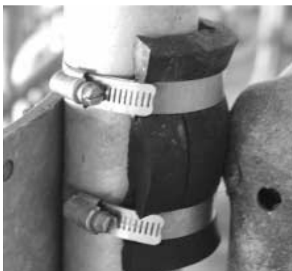
Gummimanschetten dämpfen den Lärm beim Anschlagen der Türen.
