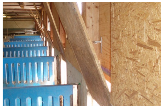
Der untere Teil der Türe lässt sich einfach mit einem Brett in Fugen schliessen.
