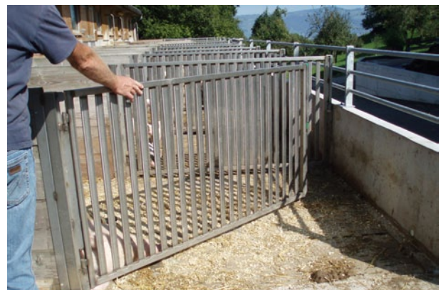
Schwenkbare Stallwände über dem Kotplatz sowohl im Stallinneren als auch im Auslauf.
