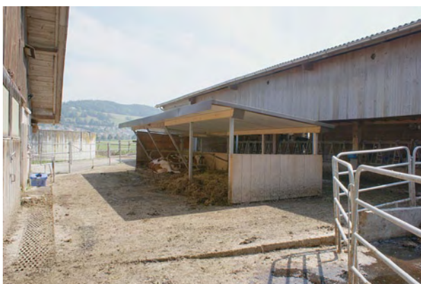
Laufhof mit kleiner Liegehalle zwischen Stall (links) und Fressplatz (rechts).
