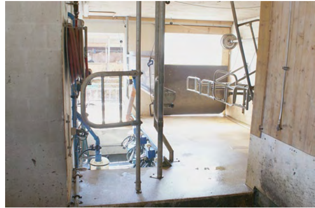
Der einfache 1 x 4 Side by Side Melkstand.
