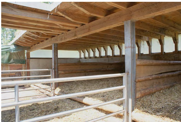
Der neue Kälberstall am Hauptstandort.
