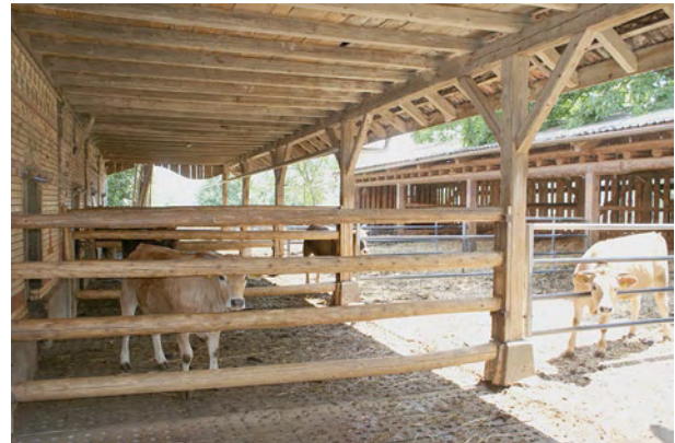
Das Vordach des alten Stalles spendet Schatten.
