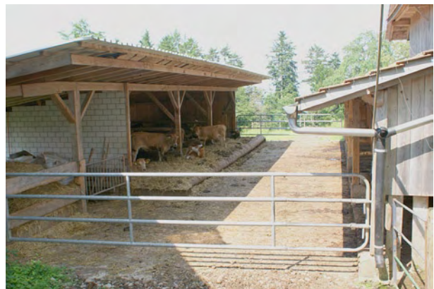
Anbau einer Liegehalle für Kälber im Steinhuser Berg.
