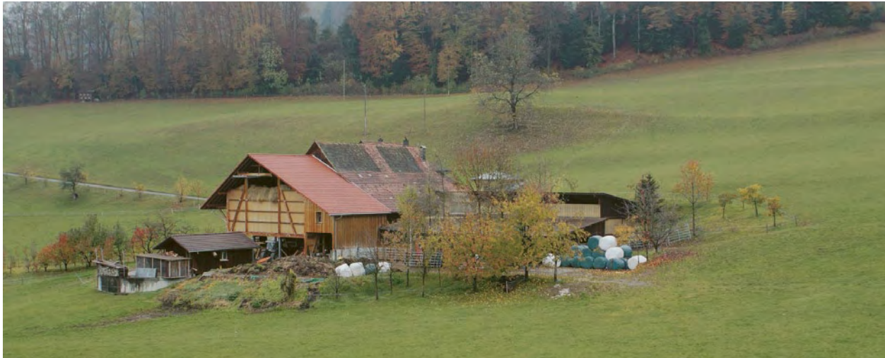
Scheune und Stall von Süden.
