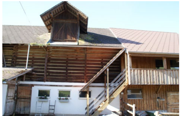
Der bestehende Stall wurde rechts erweitert.
