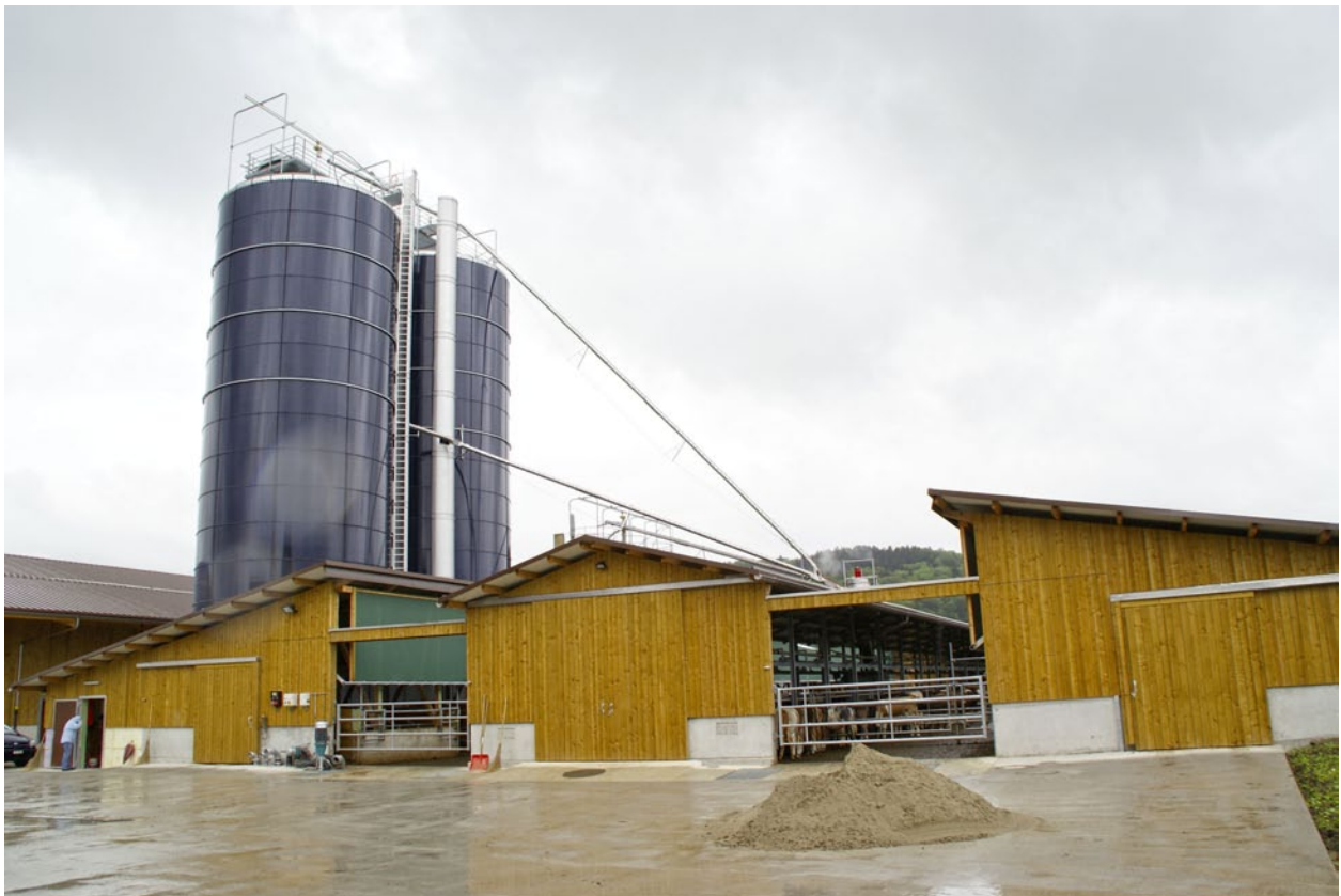
Frontansicht des zweireihigen Munimaststalles.
