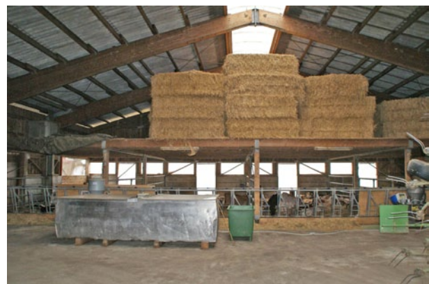
Der Hallenstall mit Firstentlüftung. Strohlager über den Kälberbuchten.
