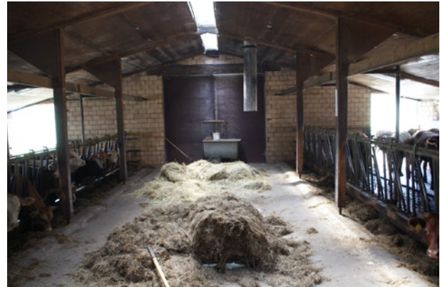
Der ehemalige Anbindestall mit Firstentlüftung.
