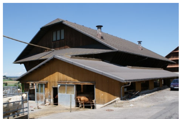
Anbau einer Liegehalle an den deckenlastigen Stall von Martin Wandeler.
