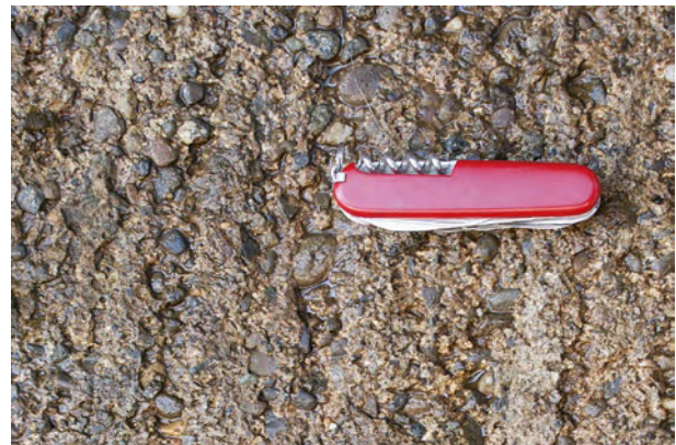
Aufgerauter Boden gegen das Ausrutschen im Wartebereich.
