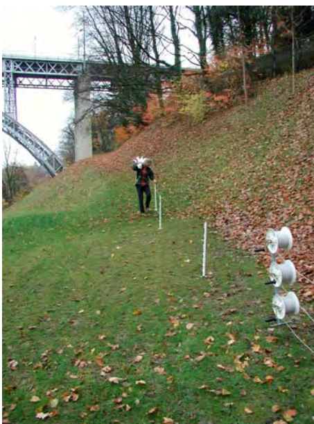
2. Stecken der Pfähle
